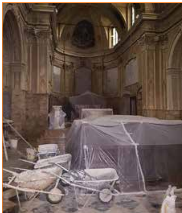
Cantiere aperto in Chiesa Parrocchiale.
