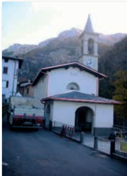
La chiesetta di Capovalle mentre si smonta il cantiere
